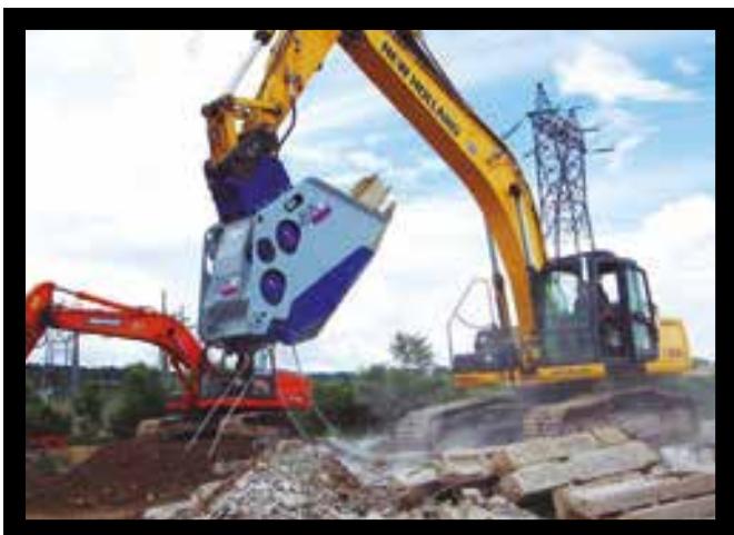
Demo de un XC30 "devorando" postes de hormigón armado.
