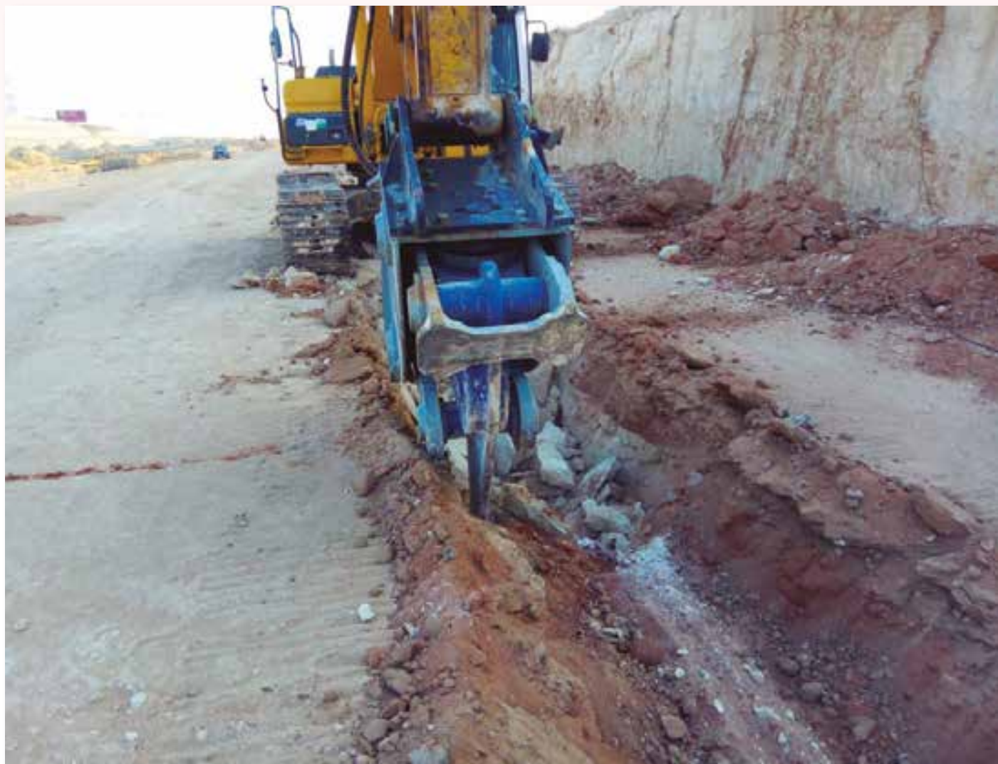
Xcentric Ripper XR20 trabajando en el proyecto de una zanja de canalización en Egipto.
