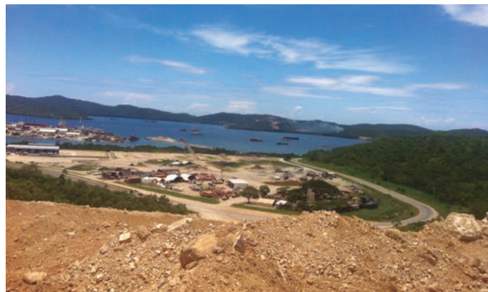
Vue d'ensemble du site d'excavation à l'île Motukea où un nouveau quai international est en cours de construction pour Port Moresby.
