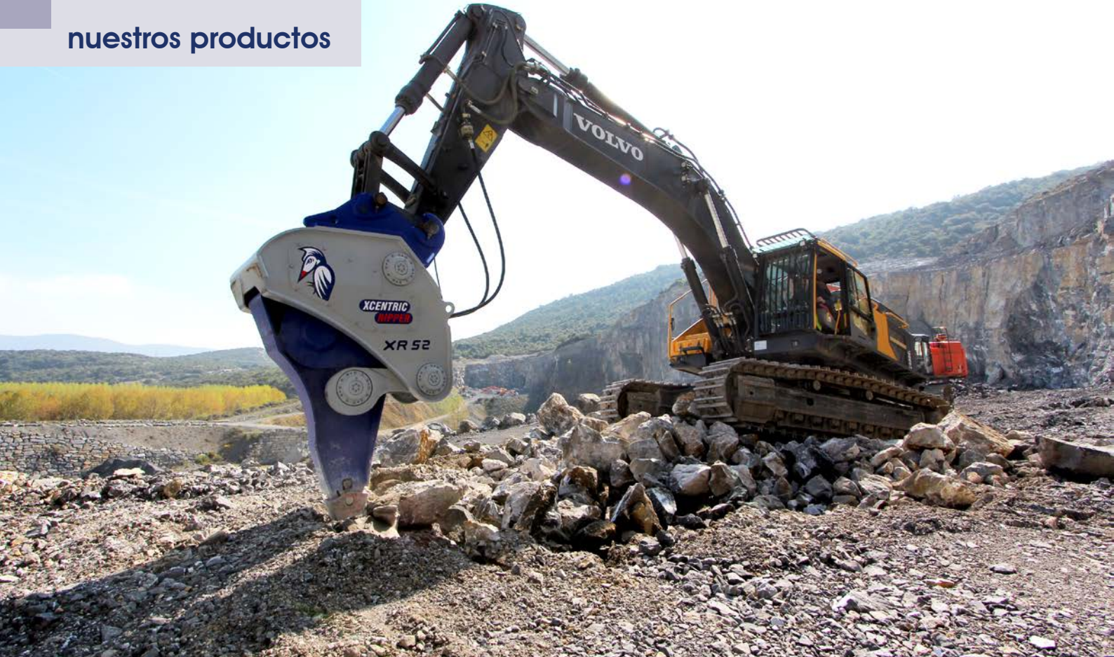
Xcentric Ripper modelo XR52 trabajando en una cantera.
