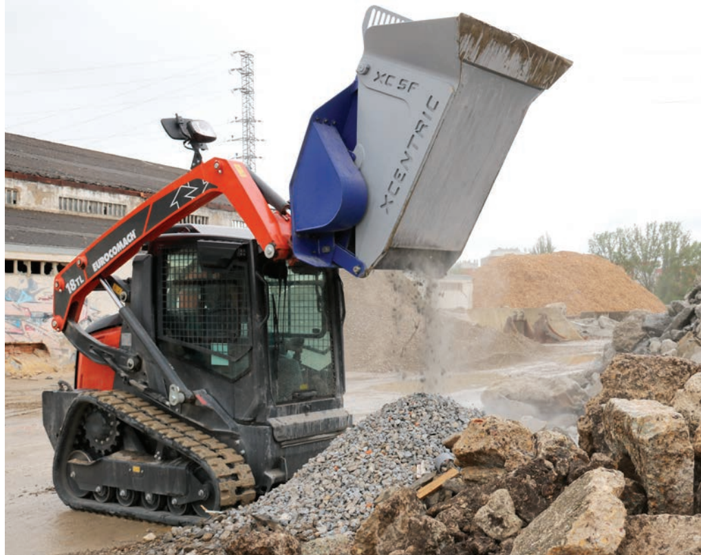
Xcentric Crusher XC5F triturando hormigón extraído de una obra.
