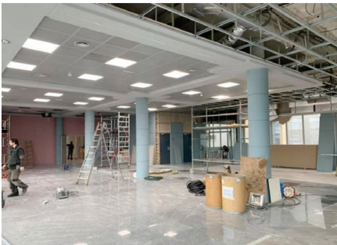
Inicio de las obras para hacer el taller de BSafe, mascarillas de protección, a mediados de abril de 2020.
