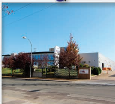
Nuevas instalaciones Xcentric / Grado Cero (2017)
