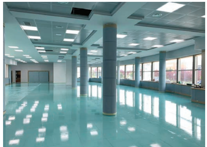
Taller casi terminado esperando la llegada de las primeras máquinas, a finales de abril de 2020.
